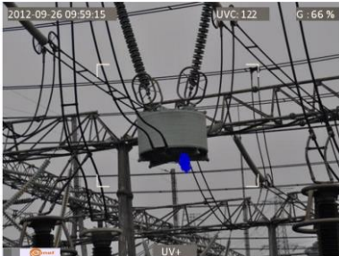
Abb. 5-8. Koronaentladung unter realen Stromnetzbedingungen.
